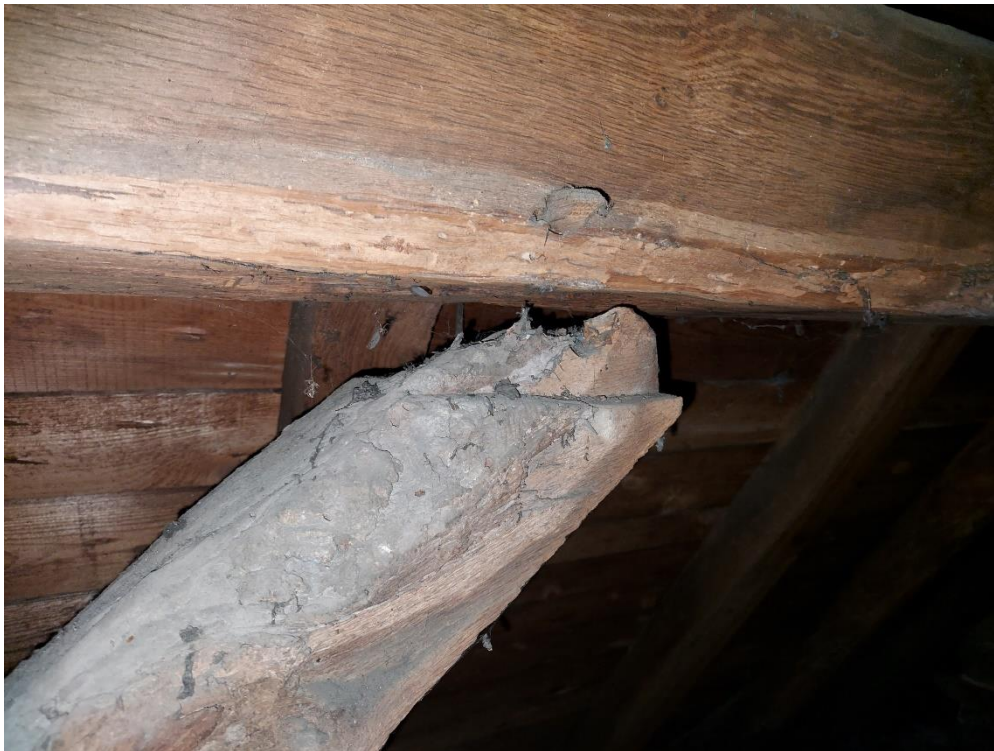
Gebrochene Zapfenverbindung zwischen der Mittelpfette und dem Kopfband
