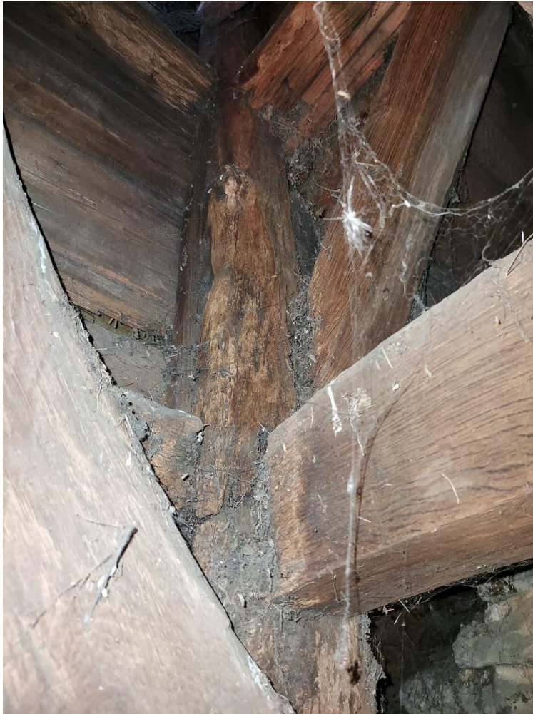
Konstruktion des Glockenturms teilweise mit Feuchtigkeitsschäden
